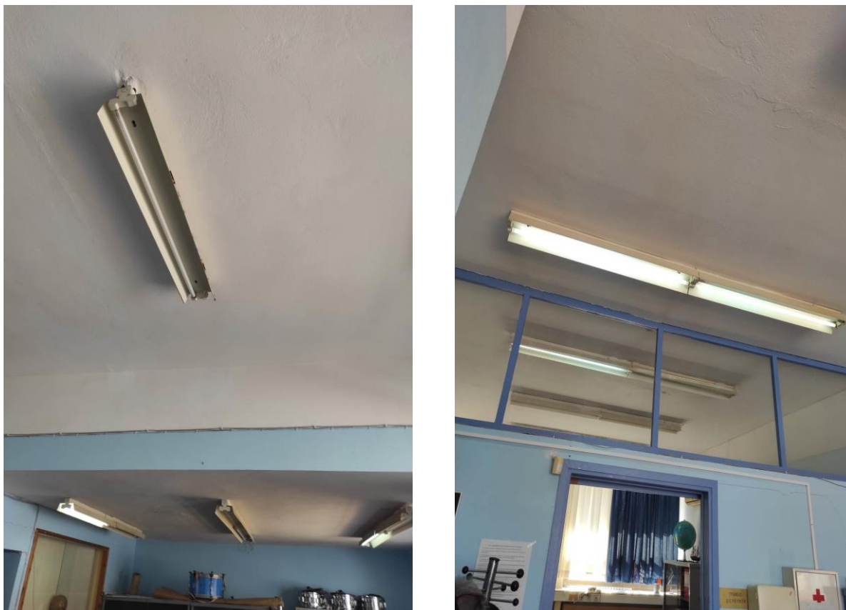
Εικόνα 7. Φωτιστικά σώματα φθορισμού 2x36 W στο γραφείο καθηγητών και στο γραφείο διευθύντριας.
